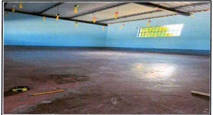
Foto 2: Sustitución de piso cerámico de aulas
