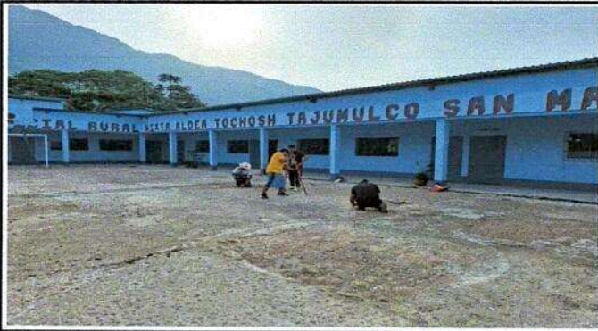
Foto 1: Reparación de piso de torta de concreto de cancha
