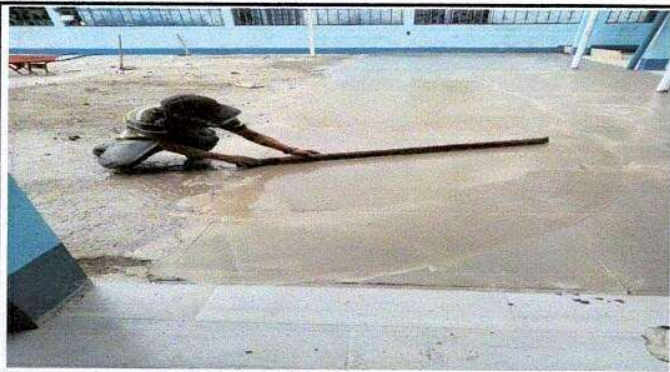
Foto 3: Reparación de piso de torta de concreto de cancha
